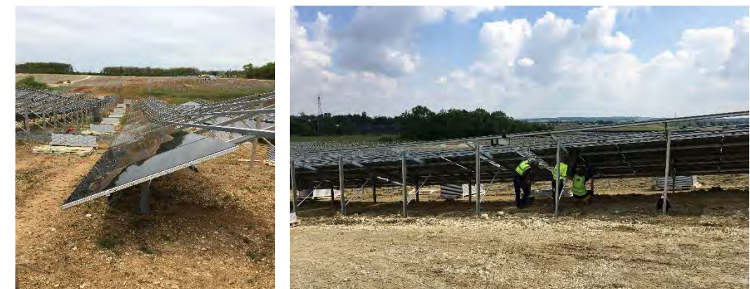
Exemples de mise en place de panneaux sur les chantiers URBASOLAR
