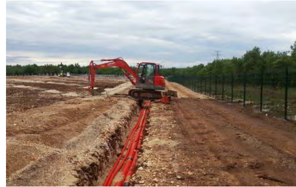
Exemple d'enfouissement de câbles électriques
