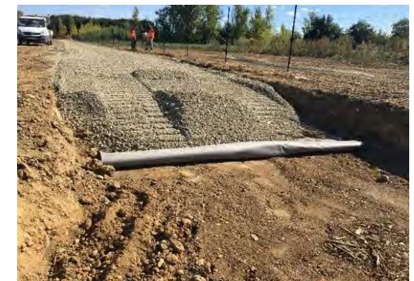
Exemple de réalisation de voie d'accès interne
