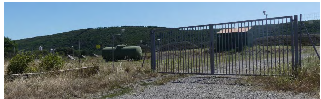
Photographie du portail gris et de la clôture grise de la centrale photovoltaïque située au Sud du projet
